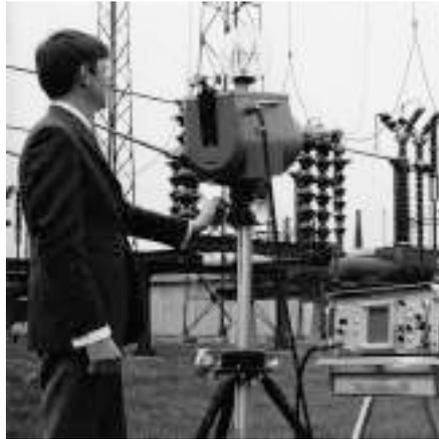
**Рисунок 21.2** 1969 г.: Thermovision модель 661. Эта камера весила около 25 кг (55 фунтов), осциллограф – 20 кг (44 фунта), а штатив – 15 кг (33 фунта). Кроме того, оператору требовался генератор переменного напряжения на 220 В и сосуд на 10 л (2,6 галлона) с жидким азотом. Слева от осциллографа видна фотопроставка Polaroid (6 кг/13 фунтов).
